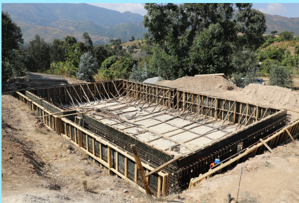
Ujenzi wa mtambo wa kutibu maji kutoka chanzo cha mto Ilunga ukiendelea
