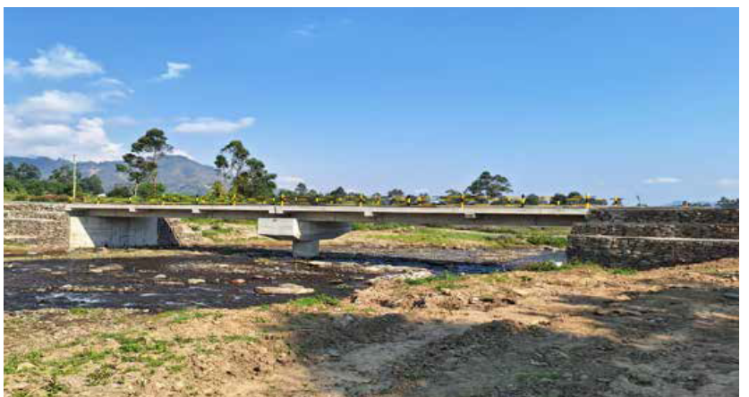
Busokelo - Ujenzi wa Daraja la Lufilyo C katika Barabara ya Luteba - Kandete.
