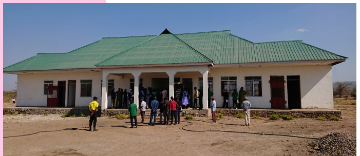
Ujenzi wa Jengo la OPD na wodi grade A lililojengwa kwa Fedha za Serikali Kuu katika Halmashauri ya Wilaya ya Chunya.
