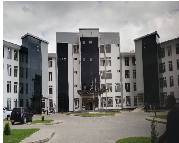
Jengo Jipya la Ofisi ya Mkuu wa Mkoa Mbeya
