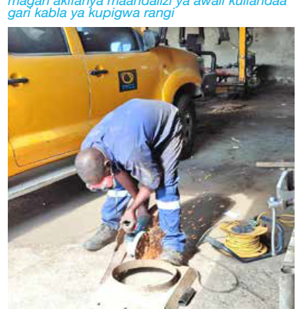
Mtaalamu kutoka kitengo cha ufuaji vyuma (welding & fabrication) akiendelea na kazi ya kutengeneza baadhi ya vifaa vya breki ya kangavuke inayotembea (mobile generator)
