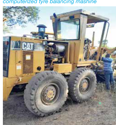
Moja wapo ya mitambo ya TEMESA Mbeya ikiendelea na ujenzi wa barabara mkoani Rukwa eneo la MUZE
