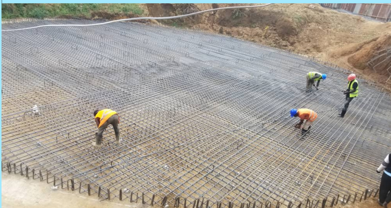
Ujenzi wa tenki la kuhifadhi maji lenye ujazo wa lita milioni 1.5 katika mradi wa kuboresha huduma za Maji Tukuyu Wilaya ya Rungwe.
