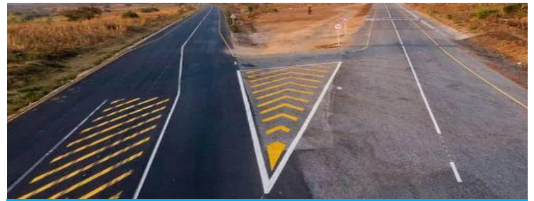
Ujenzi wa barabara ya Mchepuo iliyojengwa eneo la Inyala Wilaya ya Mbeya
