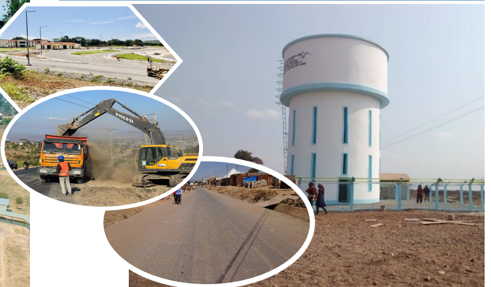
Mradi wa Maji Kijiji cha Sangambi Halmashauri ya Wilaya ya Chunya uliotekelezwa kwa fedha za UVIKO 19 katika mwaka 2021/22.
